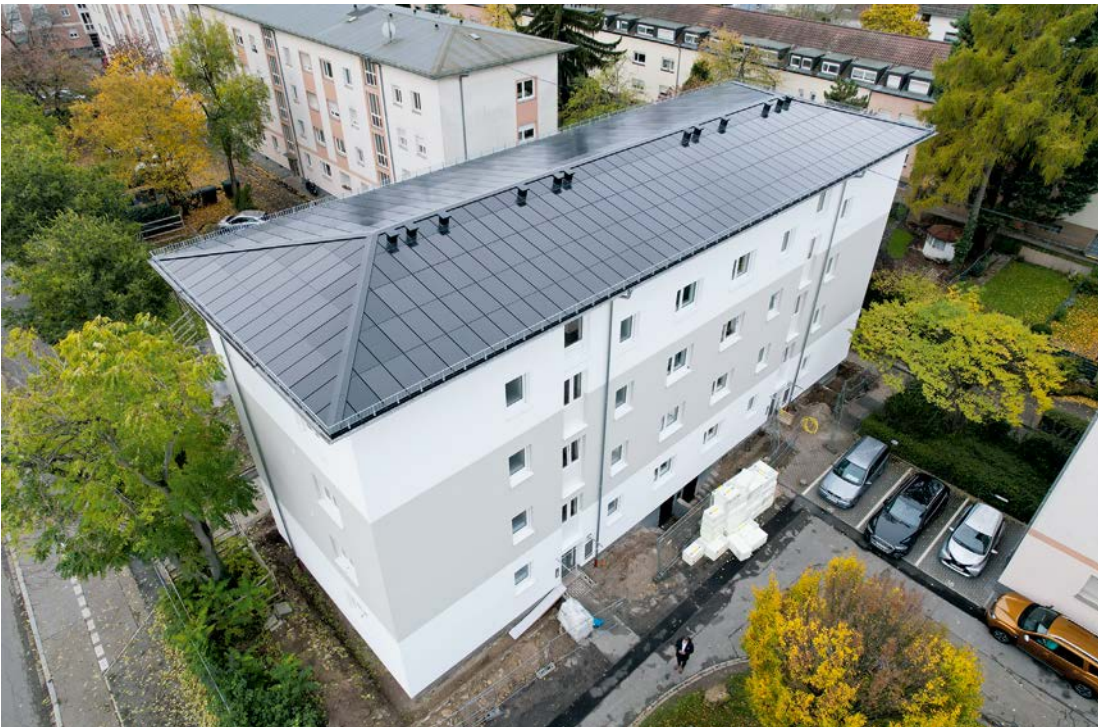
Bei kommunalem Wohnungsbauprojekt wie diesem in Mannheim kann das Ennogie-Solardach im Zusammenspiel mit neuen Konzepten für Mieterstrom für eine rundum positive Bilanz sorgen.
